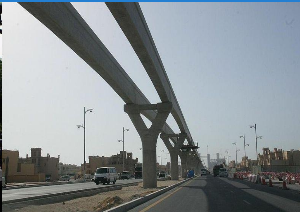
迪拜单轨连续轨道梁
