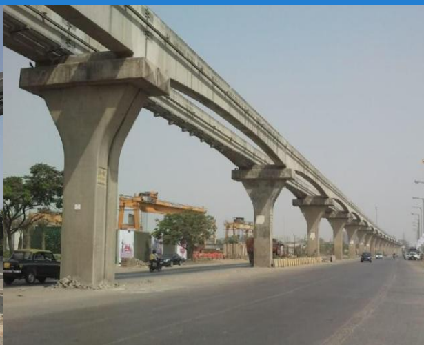
印度孟买单轨连续刚构轨道梁
