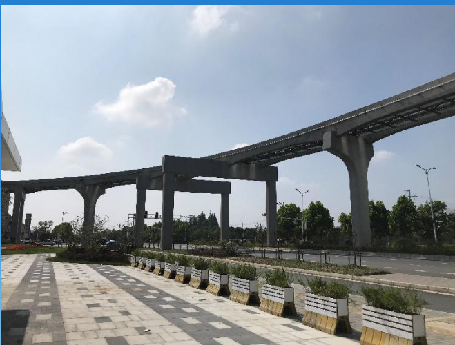
芜湖单轨连续刚构轨道梁
