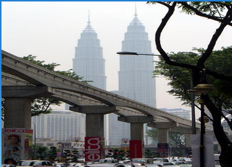
马来西亚单轨连续轨道梁
