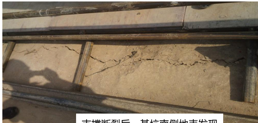
支撑断裂后，基坑南侧地表发现长数十米，宽约1cm的裂缝。
