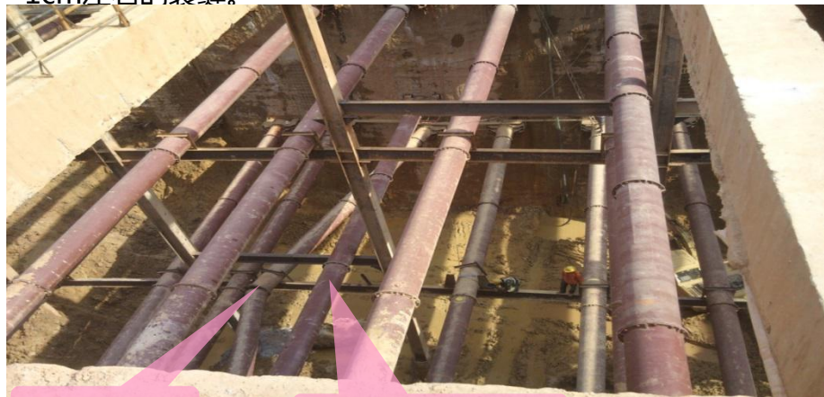
断裂的支撑
