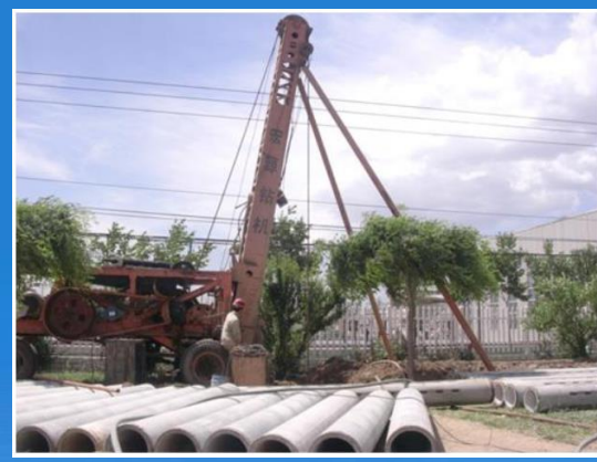
水文试验钻井施工
