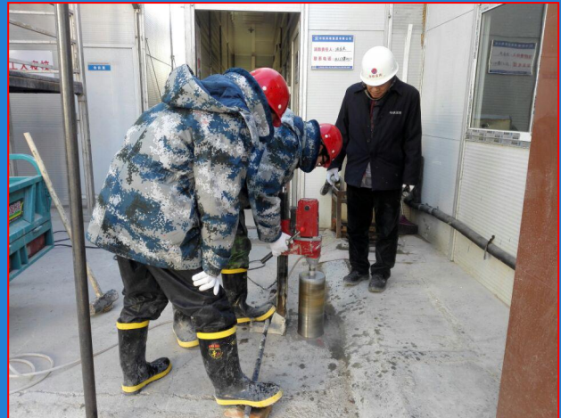
水钻钻孔破除硬化层
