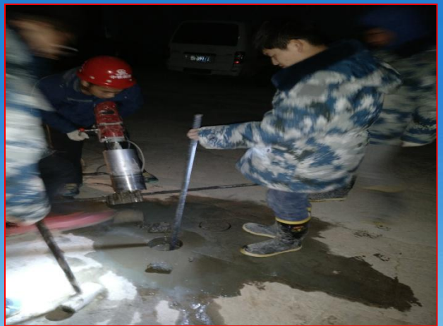
植入钢筋细沙回填
