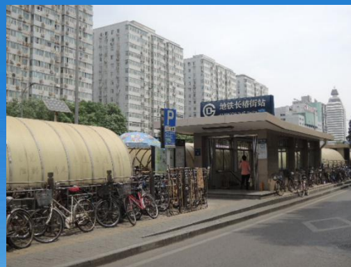
2号线长椿街站
