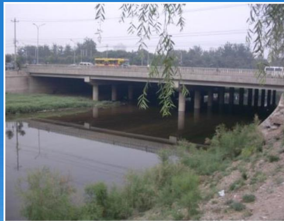
凉水河现状照片
