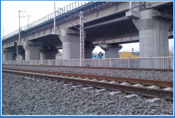
京九铁路路轨及京沪高铁桥墩
