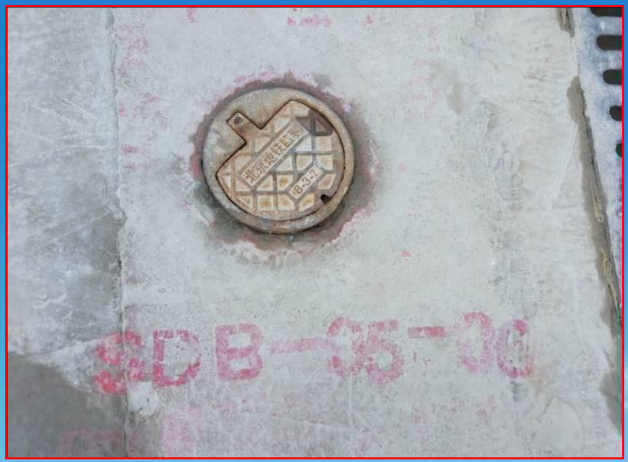
安装保护护筒并喷涂测点编号
