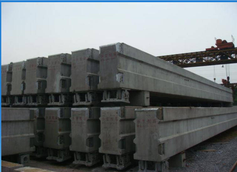
简支梁双层存梁
