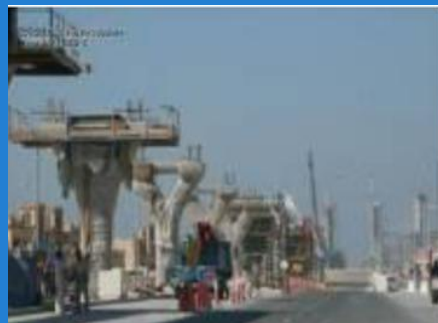
搭设临时支架
