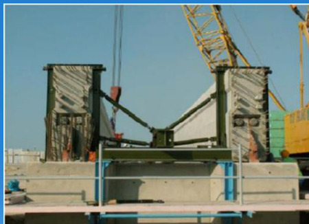
采用临时固定设施固定轨道梁
