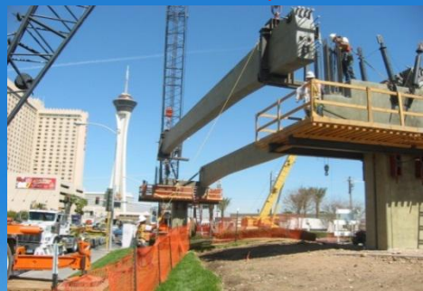
PC轨道梁吊装
