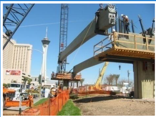
PC轨道梁吊装
