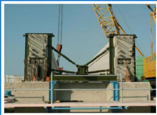
采用临时固定设施固定轨道梁
