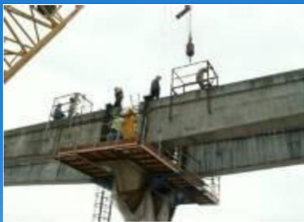
绑扎接头钢筋，贯穿通长钢绞线
