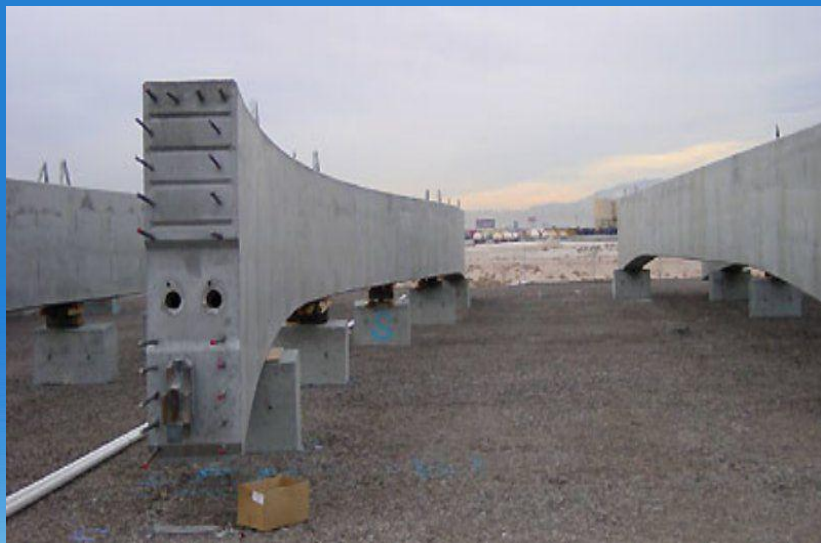
连续梁单层存梁
