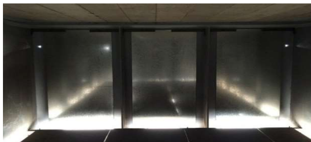
钢腹板内侧敷设约束阻尼层照片
