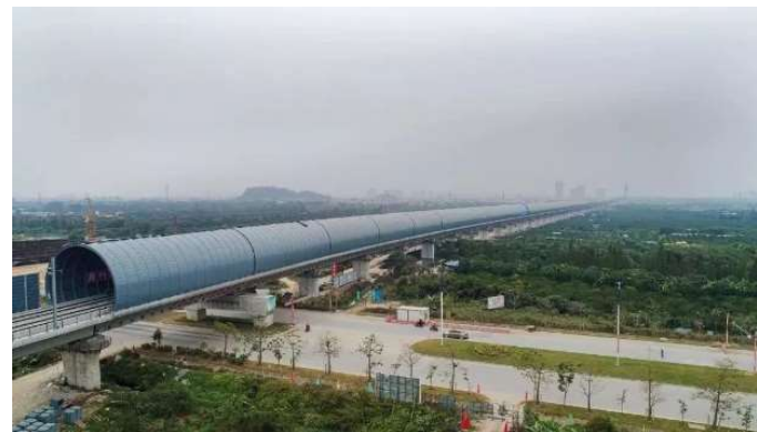
深茂高铁首次采用全封闭声屏障
