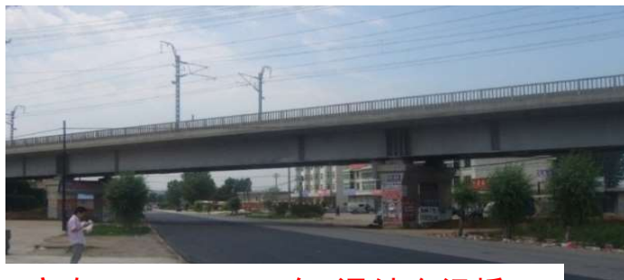
客专(32+40+32) m钢-混结合梁桥
