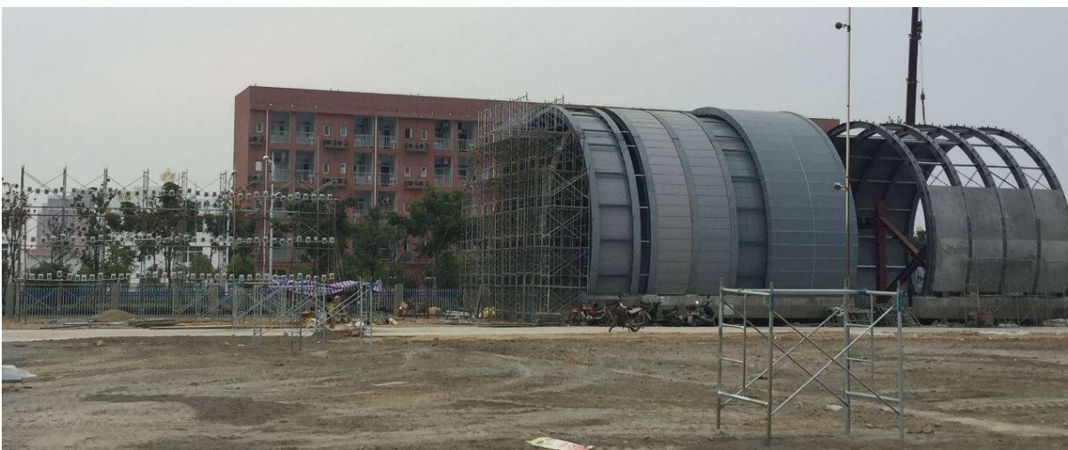
深茂高铁全封闭声屏障 振动与噪声 现场试验：传声器阵列 2015
