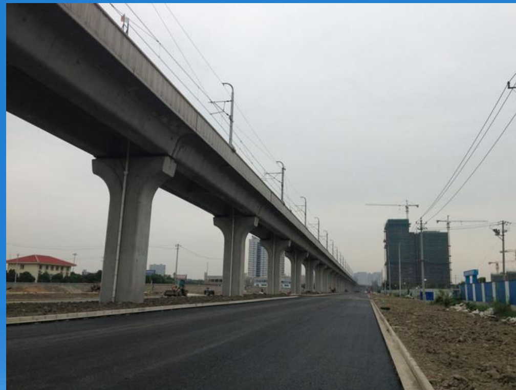
上海地铁11号线
