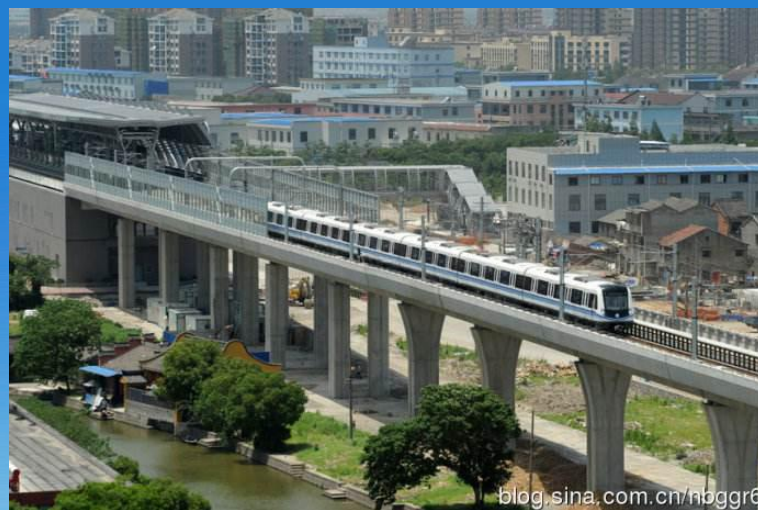
轨道交通高架线路
