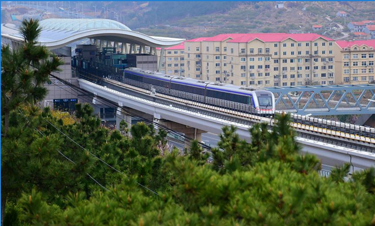
青岛地铁11号线
