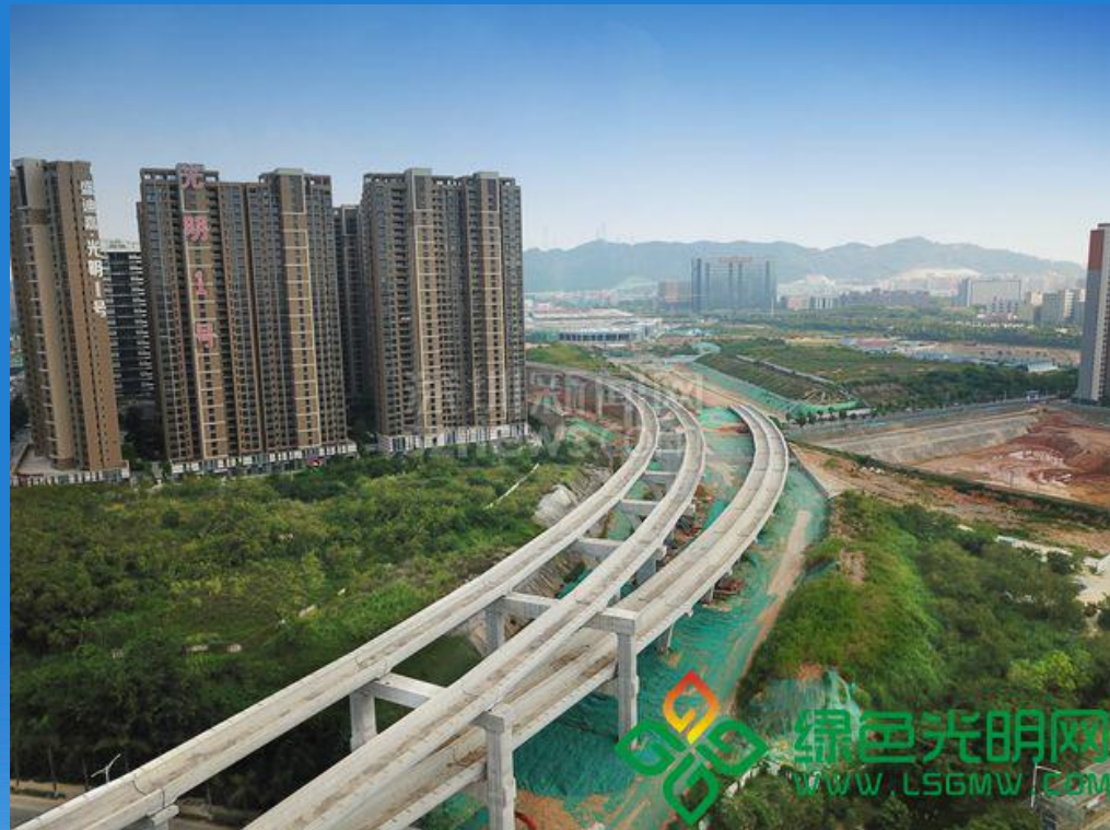
深圳地铁6号线
