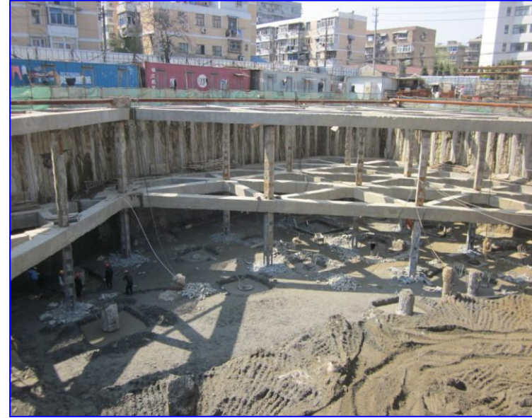
PRC桩用于基坑支护
