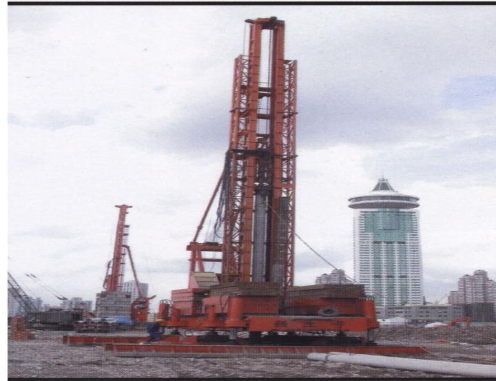
顶压式液压压桩机
