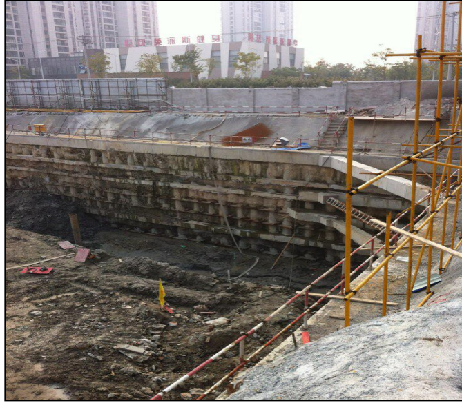
PRC桩用于基坑支护
