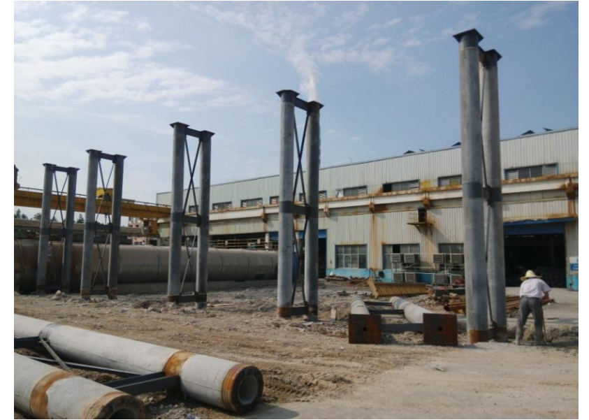
PRC桩用于堆场立柱
