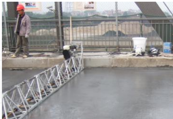
浇注成型混凝土
