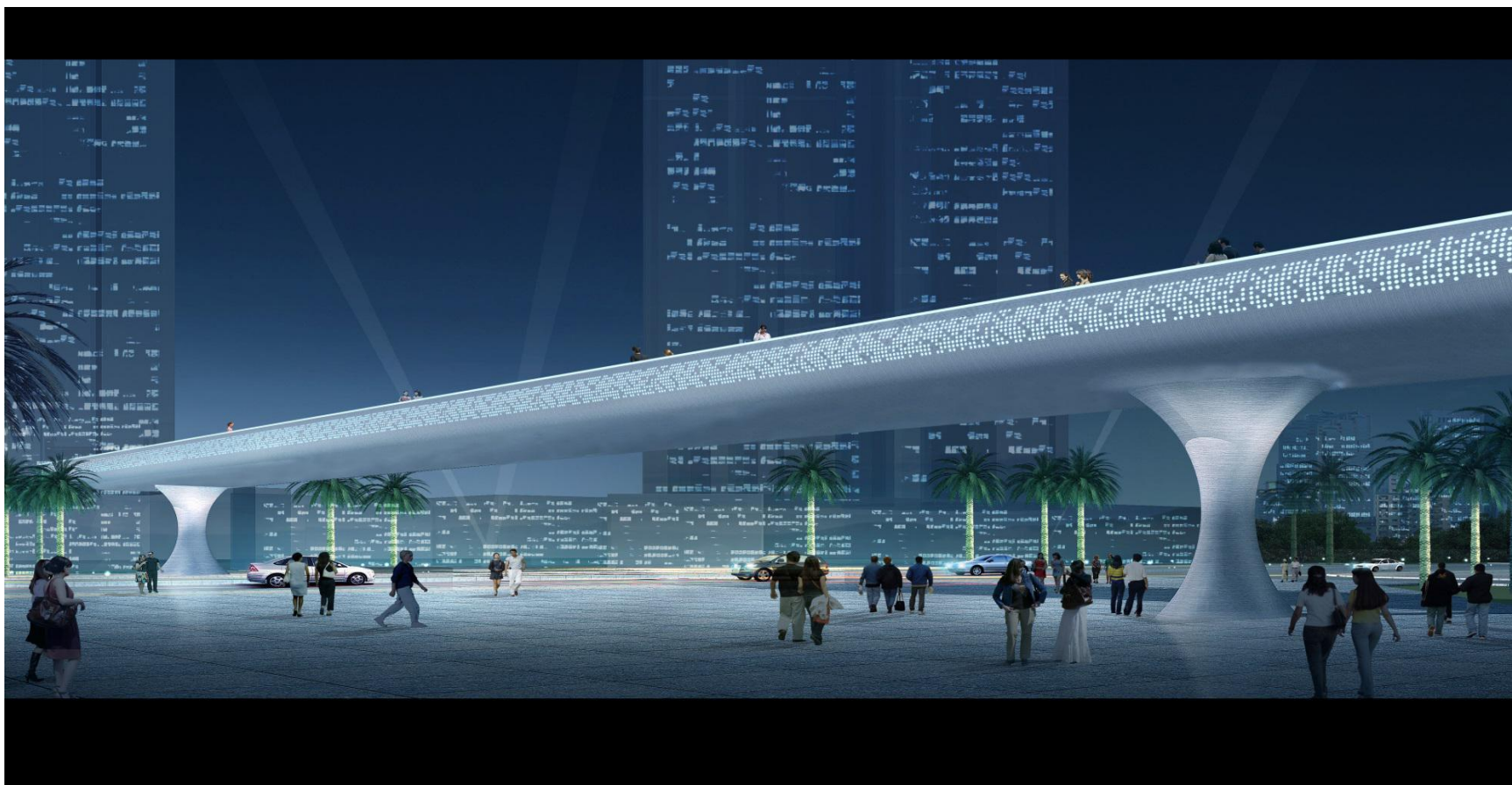
长沙横四路跨街天桥（两跨连续27.6+36.8+6.4m悬臂）
