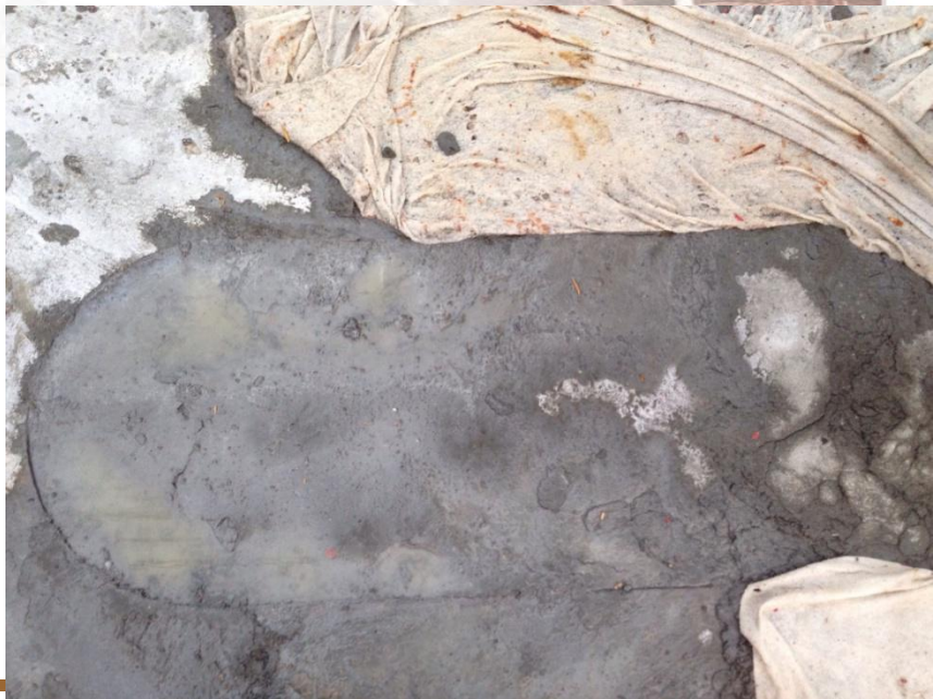
养护后的UHPC
