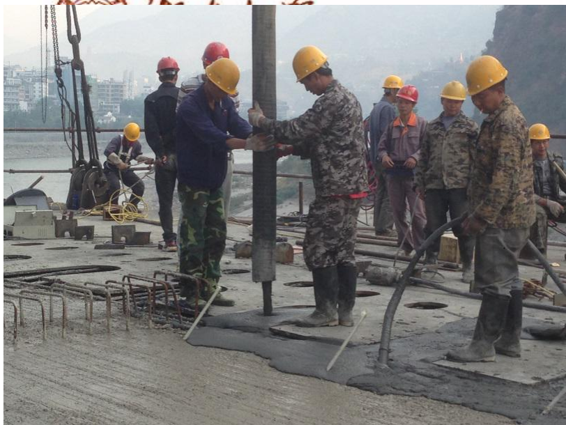
结合段UHPC灌注
