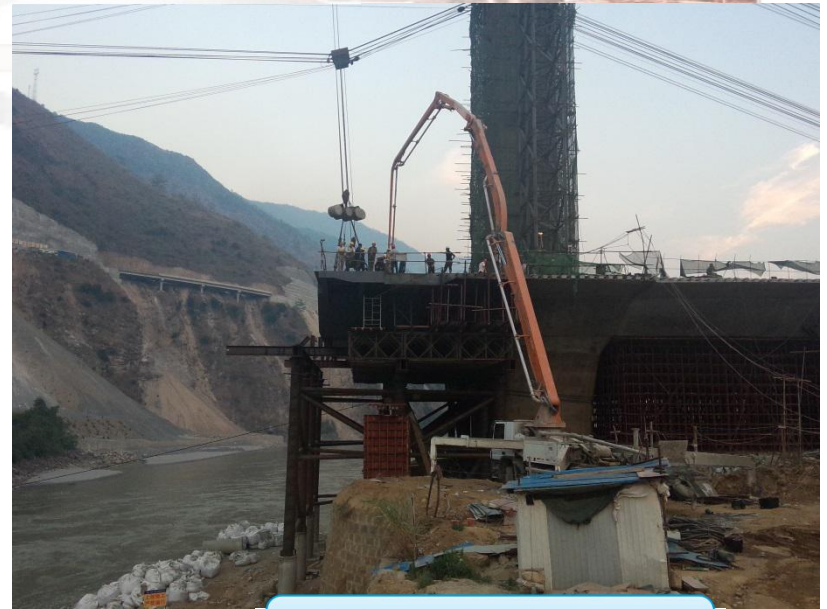
混凝土泵车施工
